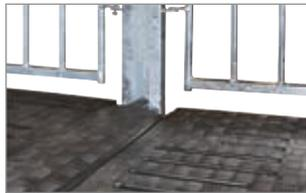
Extrémité de la réglette prévue pour s'encastrer parfaitement dans les poteaux PE en lieu et place des cloisons PE limitant le risque de passage des sabots des veaux.
